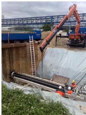
Einbau von einem oder mehreren Medienrohre als Bündel in das Stahlschutzrohr auf Gleitkufen. Auf Kundenwunsch können wir den Ringraum zwischen den Rohren auch gerne verdämmen.
